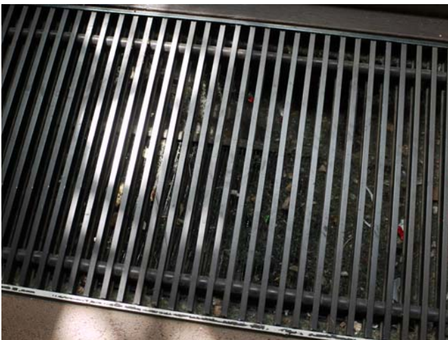
Detail Bodenheizung
