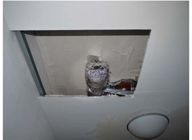
Revisionsöffnung abgeh. Decke
